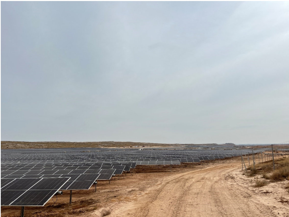
Figura 2 Montaje de los módulos fotovoltaicos
