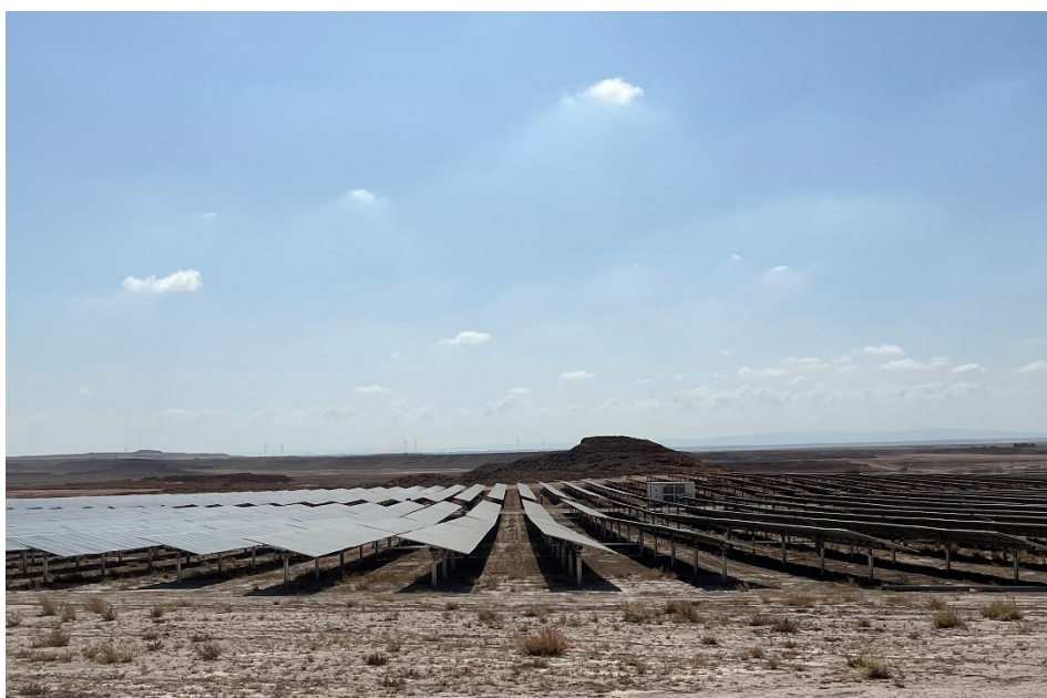
Figura 7 Montaje de los módulos fotovoltaicos
